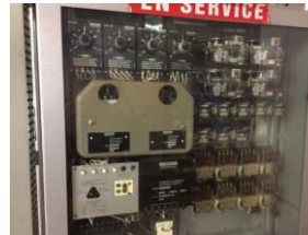
RXAP Электромеханическая дистанционная защита
