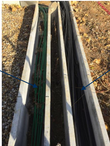
Лоток со старым медным кабелем
