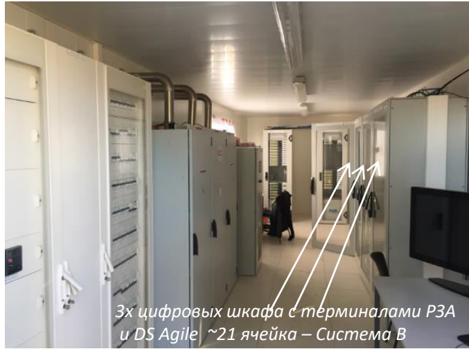
Защита трансформатора с PD3A дистанционной защитой
